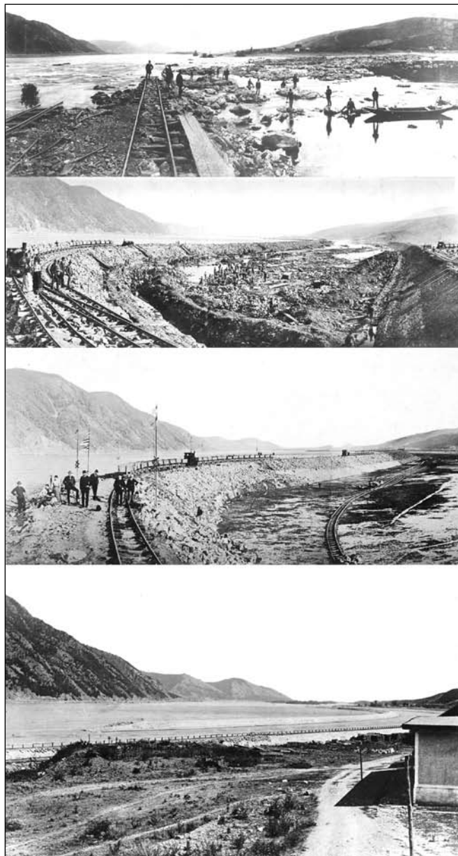
A Vaskapu-csatorna építése szakaszolva
