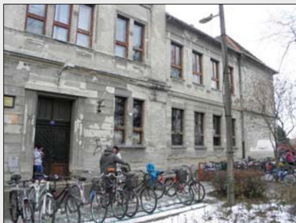
Tetőfelújítás és ablakcsere várható
