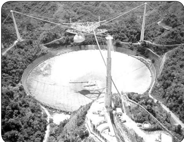
Az Arecibo, a világ legnagyobb rádiótvészóvénének tányérrésze fogja fel a világűrbeli érkező jeleket és a tányér felett magasodó vevőorszába irányítja
