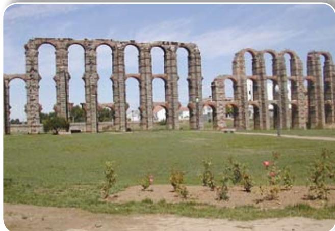
Aqueducto de los Milagros
