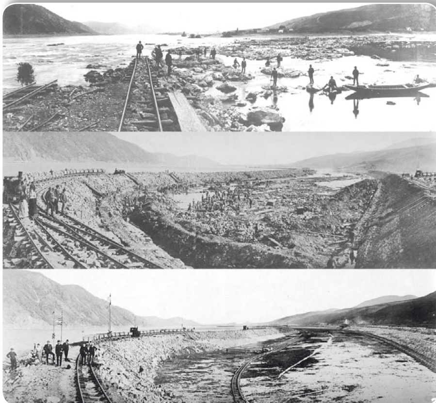
A Vaskapu-csatorna építése
